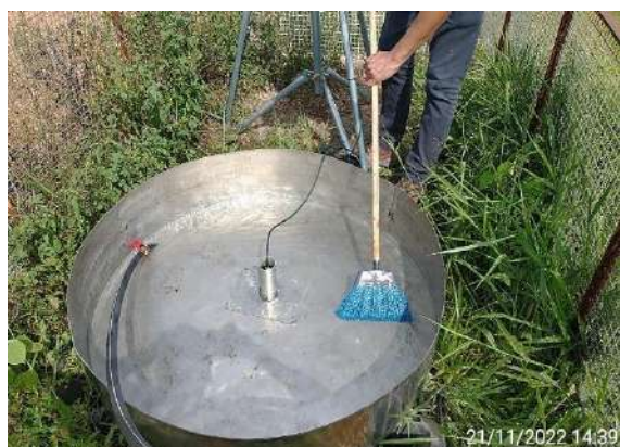
Foto 3 – Realização da atividade de limpeza da EMA. (Data: 21/11/2022).
